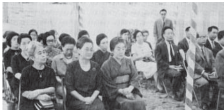
新会館着工（くわ入式）
